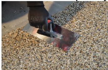
Smíchanou a připravenou směs epoxidového pojiva a kameniva aplikujeme na připravený povrch a stahujeme vodováhou, deskou (u velkých ploch) nebo hladítkem (u malých ploch). Stažený povrch v požadované tloušťce **důkladně zatahujeme hladítkem** do hladka a kontrolujeme vizuálně.
