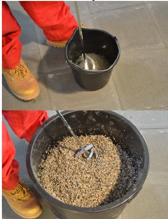
Tvrdidlo epoxidové pryskyřice (složku B) nalijeme do základu epoxidové pryskyřice (složku A). Směs složek A a B důkladně promícháme po dobu 3 minut pomocí míchadla s rychlostí 300ot./min.
