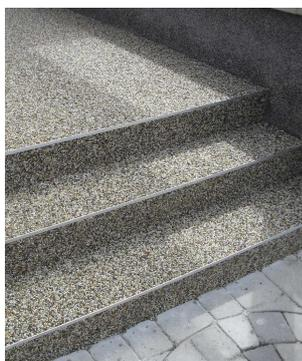
Hlavní postup při renovaci schodů je stejný jako u pokládky plochy. Podstupnice doporučujeme ošetřit penetračním EPOXY nátěrem nebo samotným pojivem pro kamenný / mramorový koberec.
